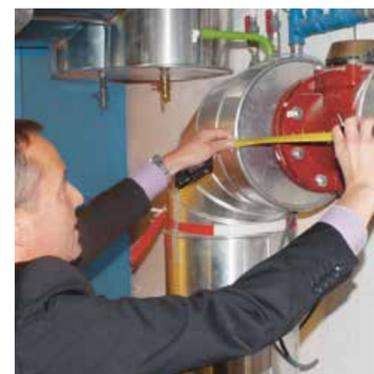
Nos spécialistes mesurent les parties à isoler et veillent à ce que les matelas isolants, sur mesure, vous soient livrés.
