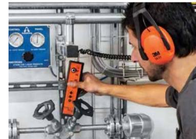
**Vérification des purgeurs de condensat sur site**
